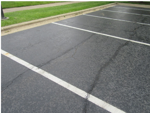
Longitudinal cracks
